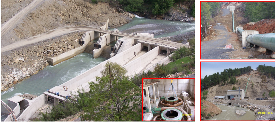
Şekil 3.20. Nehir tipi hidroelektrik santralde nehirten suyun alındığı, iletildiği yapı ve santral binası
