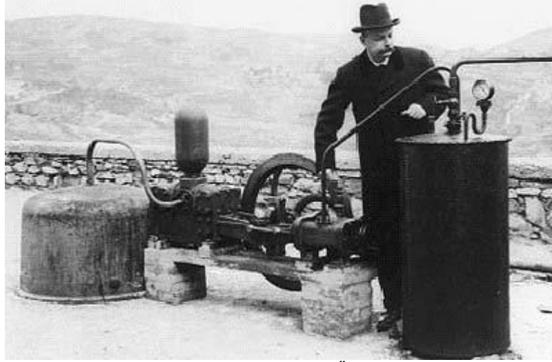
Şekil 3. Larderello Buharlı Elektrik Üretimi (John, 2004)
