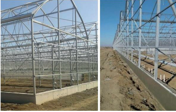
Şekil 2 . Çevre Temel ve Yan Perde Betonlu
